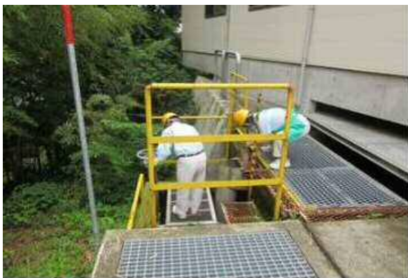
重油漏洩の連絡を受けて工場排水最終ゲート閉鎖
